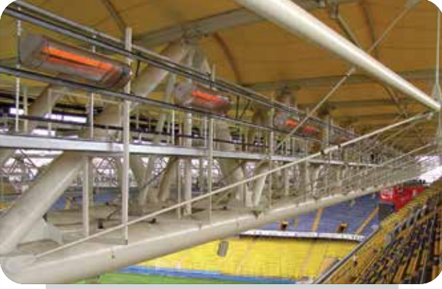
Ürün : Stadyum Tribün Isıtıcısı Uygulama : Tribün Isıtma Sistemi
