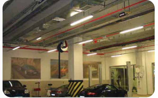
Ürün : Borulu Radyant Isıtıcı Uygulama : Araç Servis İstasyonu Isıtma Sistemi
