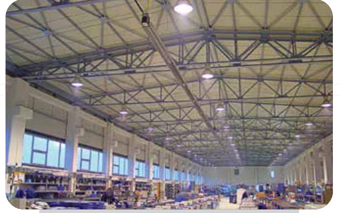
Ürün : Borulu Radyant Isıtıcı Uygulama : Fabrika Isıtma Sistemi
