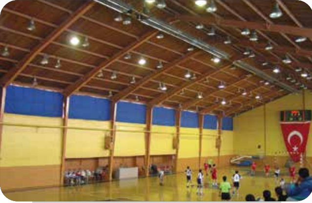
Ürün : Borulu Radyant Isıtıcı Uygulama : Spor Salonu Isıtma Sistemi
