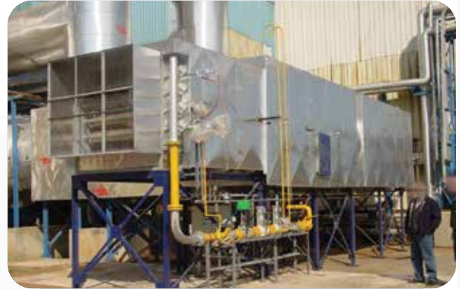
Ürün : Endüstriyel Proses Brülörleri Uygulama : Kojenerasyon Isı Destek Ünitesi
